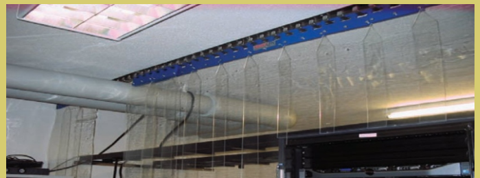
Một vách ngăn nhiệt được lắp đặt trong trung tâm dữ liệu cho phép giảm nhiệt độ của phòng để tiết kiệm điện năng và đảm bảo điều kiện làm mát cho các thiết bị.
